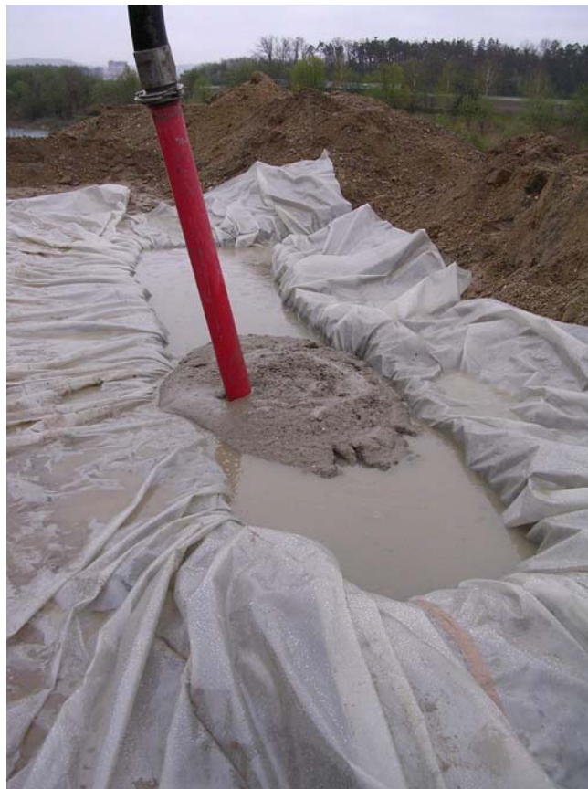
Abb.1 : Verfüllversuch mit „Stollen-SSM-steif“
